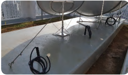
- 안테나용 동축케이블 마감처리 불량으로 우수 유입 문제
