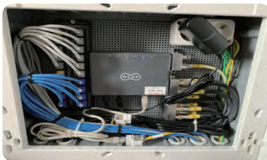
망 분리를 위한 세대단자함 내 망분리 단말장치 설치
