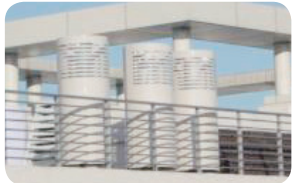
아파트 건물과 조화를 이루도록 위장 · 은폐하여 인지가 어려운 친환경 기지국을 설치
