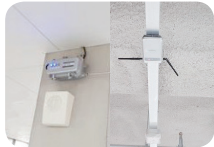
FM/DMB 재전송 설비의 커버리지를 측정하여 음영지역 보완 시공
