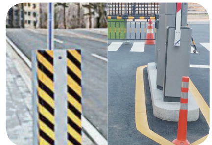
인도 및 차도 주차차단기 안전시설 (안전펜스, SUS안전봉, 탄력봉) 설치
