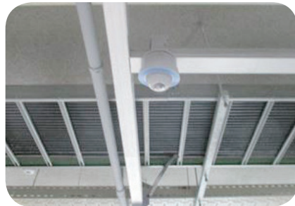
지하주차장 내 CCTV 카메라에 유지관리용 위치 식별번호(방재실 모니터와 동일표기내용) 미부착
