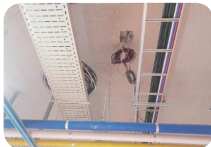
주차장 내 Cable Tray 내 공사 마감 불량으로 유지관리에 위해 요인 발생
