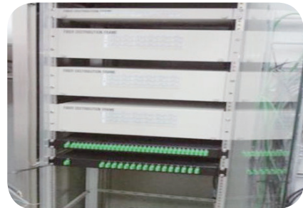
홈네트워크 단지 서버 시스템을 별도의 랙으로 통합 및 보안 관리 시행
