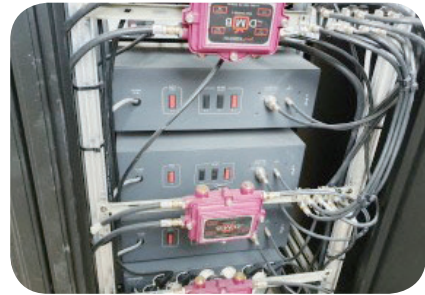
DMB Repeater 설비를 방재실에서 일괄 비상전원 공급방식으로 시공
