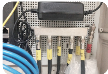
TV분배기 종단기(Dummy) 설치
