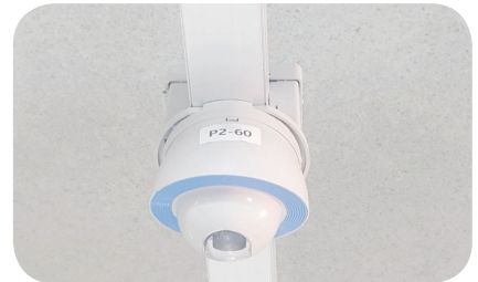
지하주차장 CCTV 카메라와 방재실 CCTV 모니터의 표기가 동일하여 문제 발생 시 위치파악 용이
