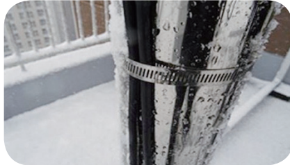
옥상 TV안테나 동축케이블 고정부위 케이블 보호조치 필요
