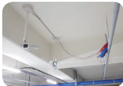
지하주차장 CCTV 설치 및 Cable의 여장정리 등의 공사 마무리 미흡
