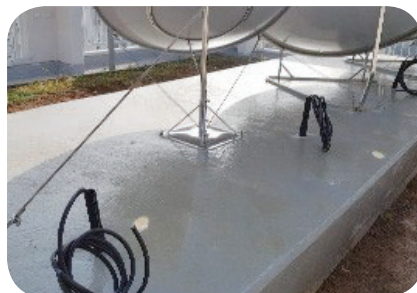
안テナ용 동축케이블 마감처리 불량으로 우수 유입 문제
