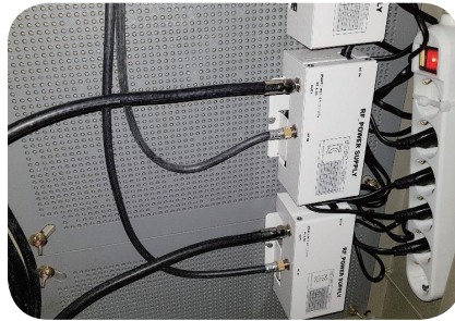
주차장 내 DMB Repeater 전원공급기에 비상 시 UPS 전원공급 안됨
