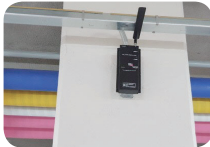
지하주차장 FM/DMB 안테나와 Tray와 간섭으로 음영지역 발생
