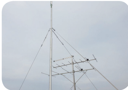
SMATV 안테나 중 DMB 안테나 방향이 다르게 시공
