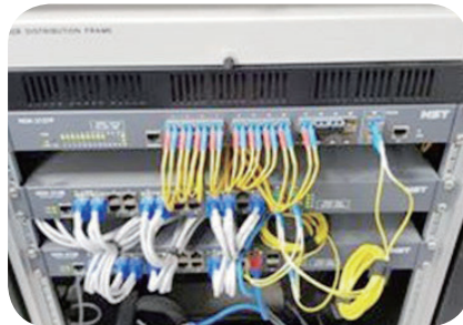
홈네트워크 단지 서버시스템 관리 불량 및 Ethernet 장비에 먼지제거
