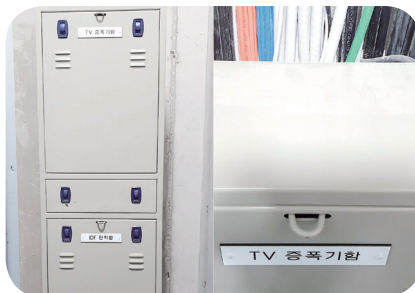
TPS실 면적 부족으로 수직트레이 위에 TV 증폭기함과 IDF 단자함을 설치
