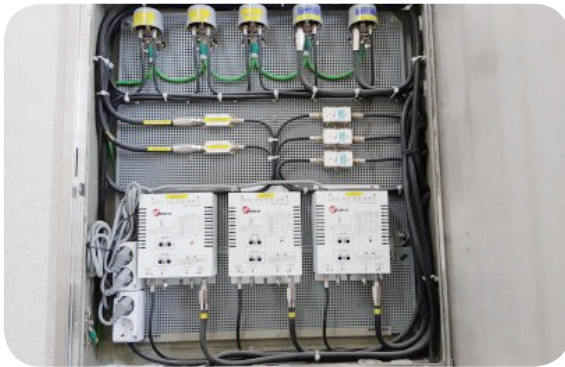
SMATV용 메인단자함 내 각 설비의 배치 및 시공 상태 우수 (배치, 접지, 라벨링)
